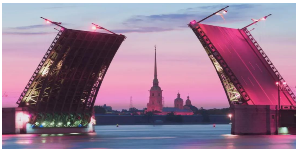
Рисунок 1 – Разводной мост г. Санкт-Петербурга
